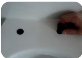
2. Put the main body on the toilet and make sure that the front of the TOPTOILET is aligned with the toilet bowl. Make a mark at the back of the toilet with a pen as indicated. Placez le TOPTOILET sur la cuvette et assurez-vous que l'avant du TOPTOILET est aligné avec l'avant de la cuvette. Faire une marque à l'arrière à l'aide d'un crayon comme indiqué sur le dessin.
