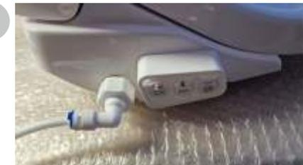
Enfoncez bien à fond (1cm environ) le tuyau dans l'orifice du connecteur pour éviter tout risque de fuite et installez la bague bleue de verrouillage
