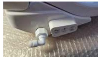
Vissez un autre connecteur sur le pas de vis de l'entrée d'eau de l'abattant, sans oublier d'y insérer préalablement un joint.
