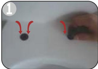
Retirez l'abattant existant et ses vis de fixation puis insérez dans les trous de la cuvette la partie caoutchouc des boulons expansifs
